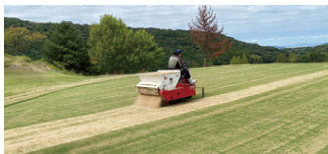
目砂を撒く作業風景
