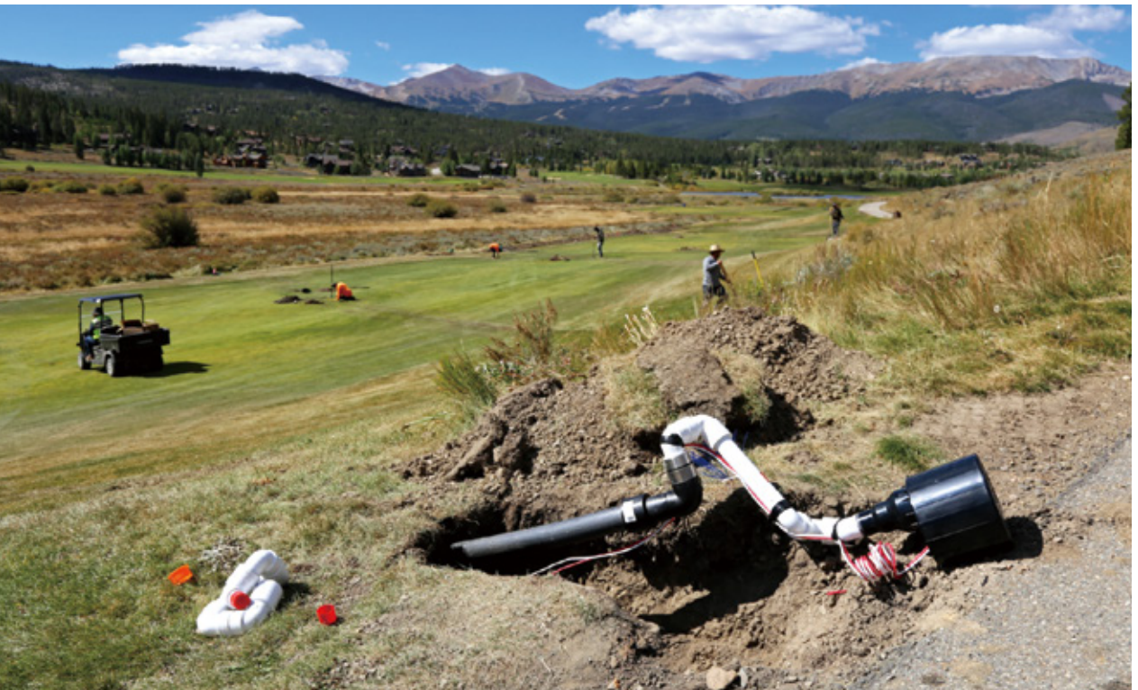
経年劣化したインフラ設備を更新することで、コースコンディションも仕事の効率も向上する
