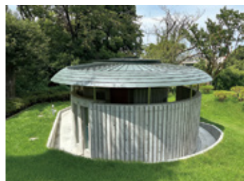
独特の形で統一されたトイレを新設
