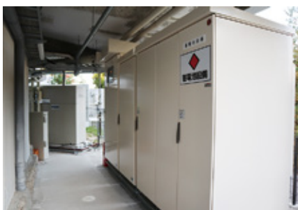
太陽光発電で得た電力を蓄えるリチウムイオン蓄電池
