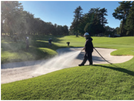
バンカーはプレートで法面を転圧し、水締め を行っていた
